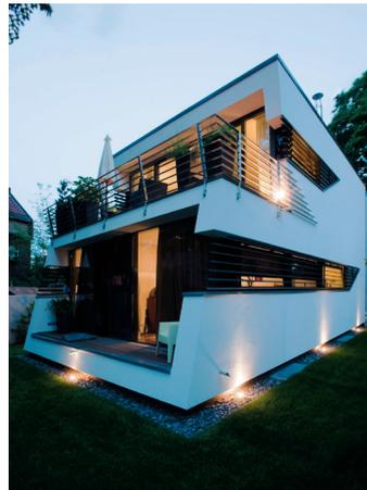
**Wärmedämmung:** Das monolithische Mauerwerk aus Ziegelsteinen benötigt keine zusätzliche Wärmedämmung
