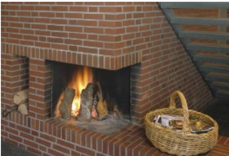
Massiv gebautes Mauerwerk kann Wärme speichern und sukzessive wieder an den Raum abgeben.
