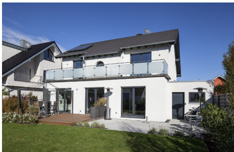
Von Robustheit bis Energieeffizienz: Mauerwerk erfüllt viele Anforderungen, die Bauherren an ihr neues Traumhaus stellen. (Foto: Burg+Schuh, www.palladium.de/Massiv mein Haus )
