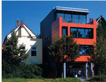
Nach der Aufstockung überzeugt das Objekt durch viele innere wie äußere Werte. (Foto: Bundesverband Porenbeton/Massiv mein Haus)
